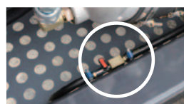
燃料タンクの水抜きコック
