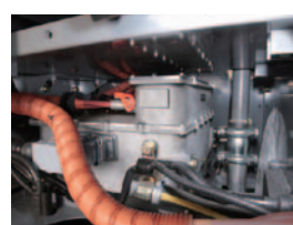
PCU (パワーコントロールユニット)
